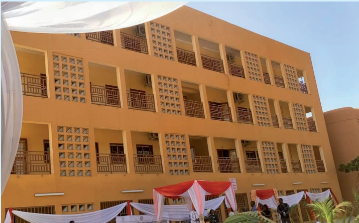
Bâtiment R+3 pour abriter l'Ecole supérieure de la statistique et des centres spécialisés.
